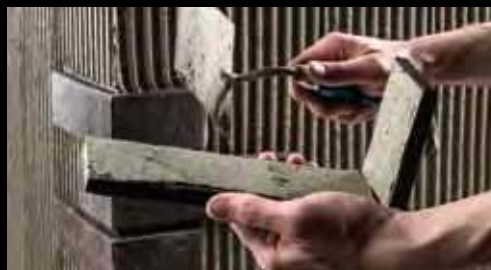
С уголками работают по методу двойного намазывания.
