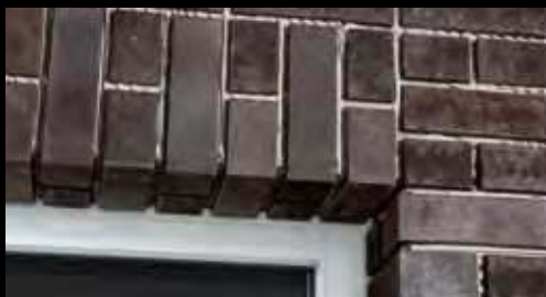
Оконный откос, превосходно выполненный с помощью углового элемента.
